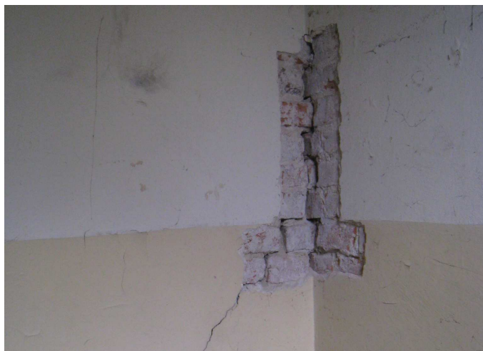
(Fot. 3 Rysa w ścianie klatki schodowej w południowo-wschodniej części pałacu)
